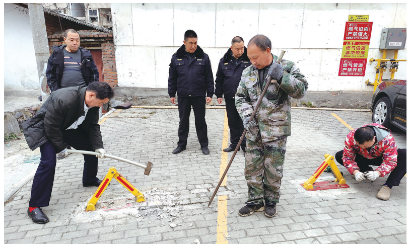
执法人员现场拆除私设的地锁。
