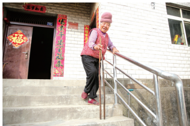
茅箭区东城经济开发区视槽村一组82岁的王吉英家门口装上了护栏。
