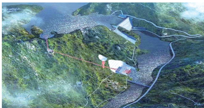
工行十堰分行为竹山潘口抽水蓄能电站发展建设提供金融支持。(资料图片)
