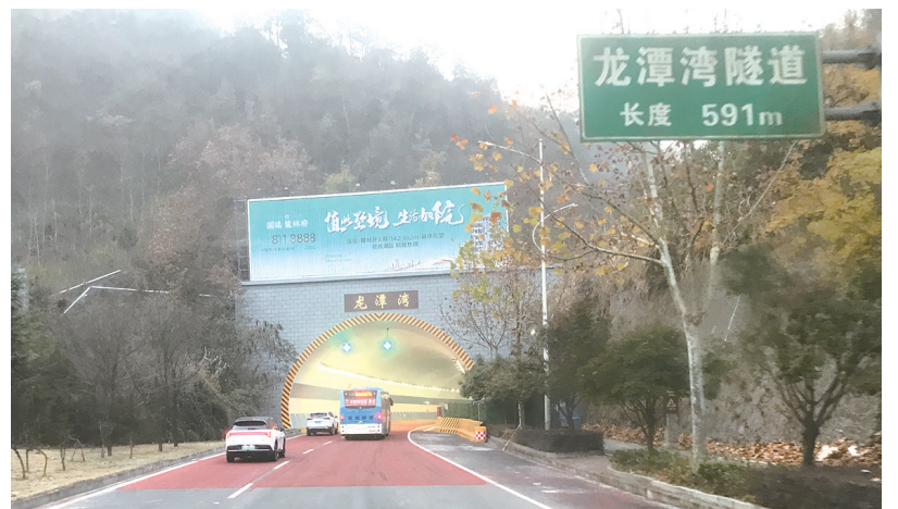
改造后的龙潭湾隧道灯光明亮,行车更安全。
