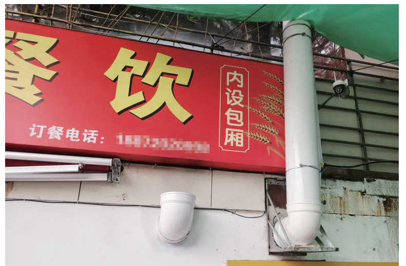
油烟净化器和排烟管道重新安装后,困扰两家的问题解决了。
