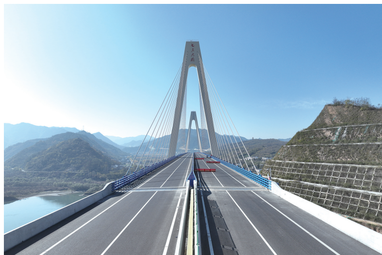
全长34.8公里的十巫北高速公路通过交工验收。
