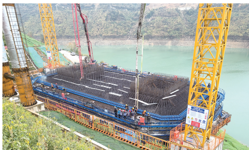
大桥主墩承台施工完成,为开启主塔施工打下坚实基础。
