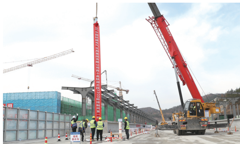
西十高铁湖北段“强电”标接触网第一杆成功组立。
