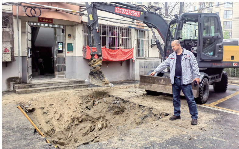
纪元在加装电梯施工现场查看进度。
