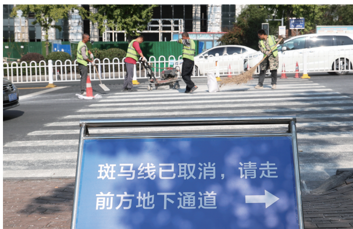
施工人员现场清除斑马线。
