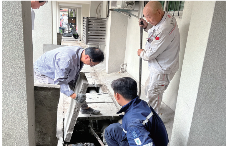
施工人员正在对供水主管道进行更换。
