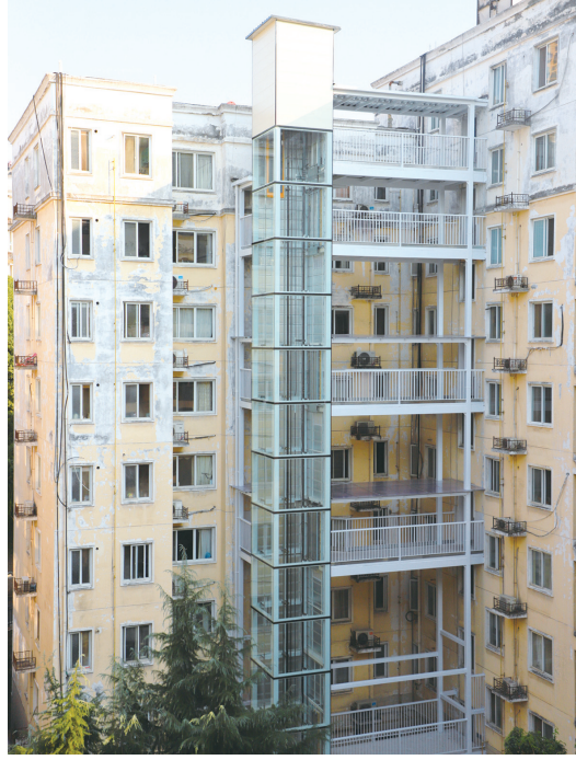
一部电梯通过连廊可服务两个单元的居民。
