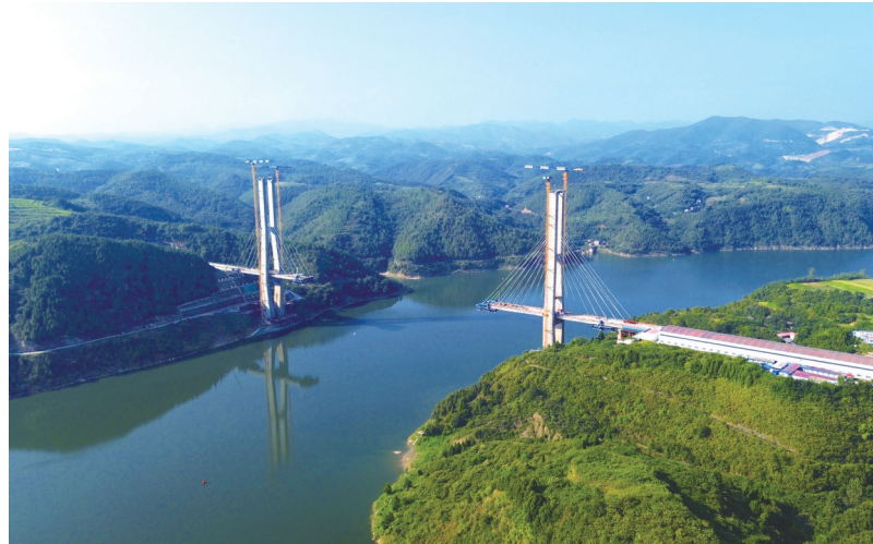
西十高铁汉江特大桥采用主跨420米斜拉桥“一跨过江”。
