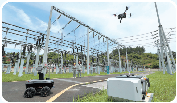
无人机、机器人配合电力作业已成常态。(资料照片)
