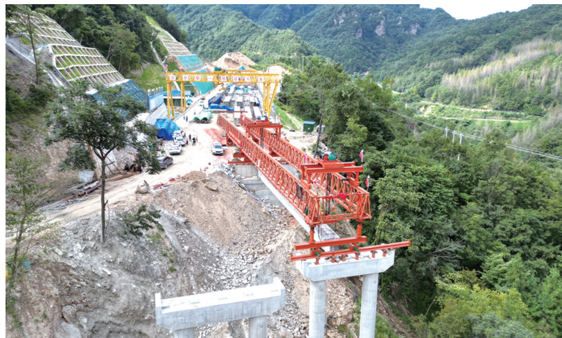
8月28日,马家院3号大桥首片T梁成功架设。
