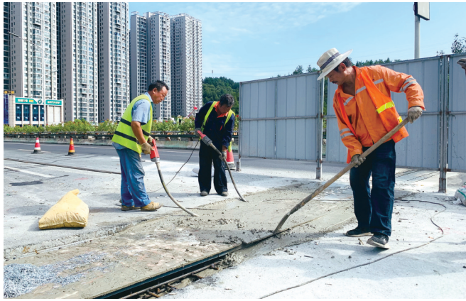
施工人员在浇筑伸缩缝混凝土。
