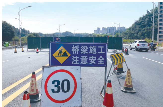
大桥两端竖起醒目的提醒标牌。
