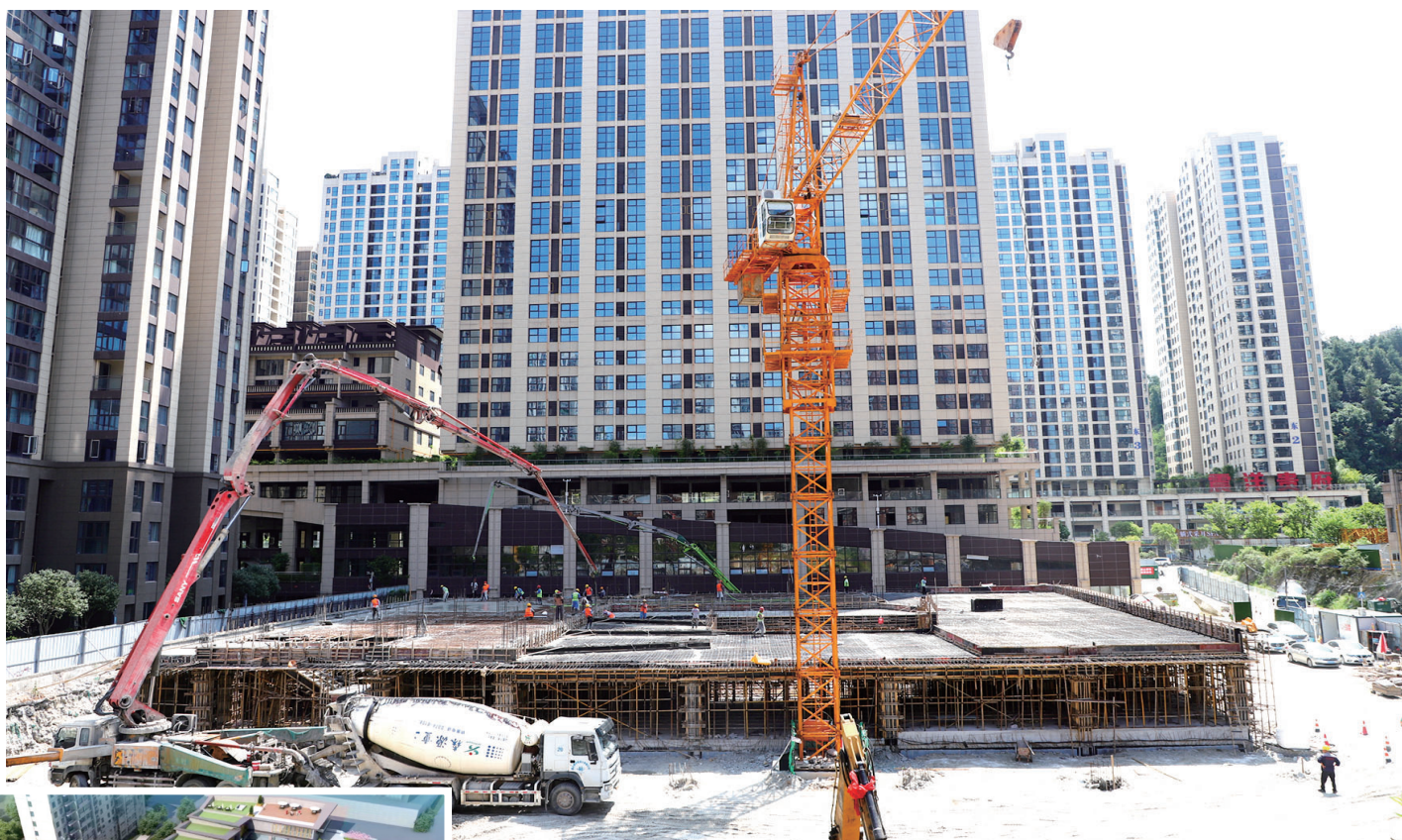
上海名都口袋公园进入主体施工阶段。
