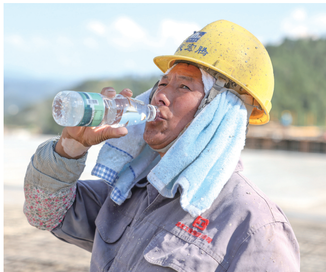
厦门路学校建筑工地,工人饮用赠送的矿泉水。
