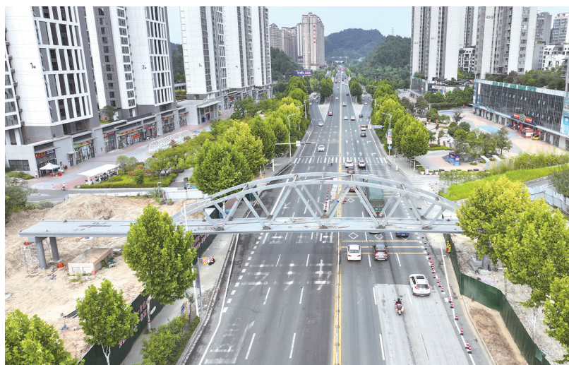
昨日,车城高中人行天桥完成钢箱梁吊装。
