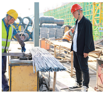
姚宝群(右)在工地检查安全生产。
