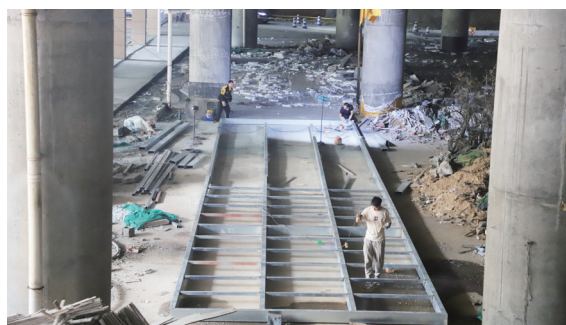
施工人员正在加紧施工。
