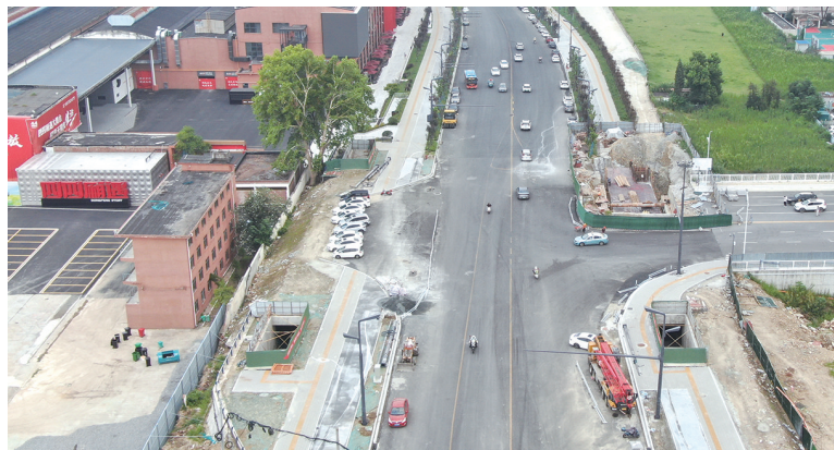
朝阳南路4号地下通道连接原44厂和新二堰桥。
