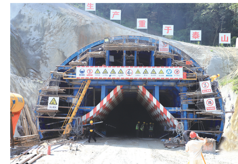
施工人员在幸福路二期2号隧道紧张施工。
