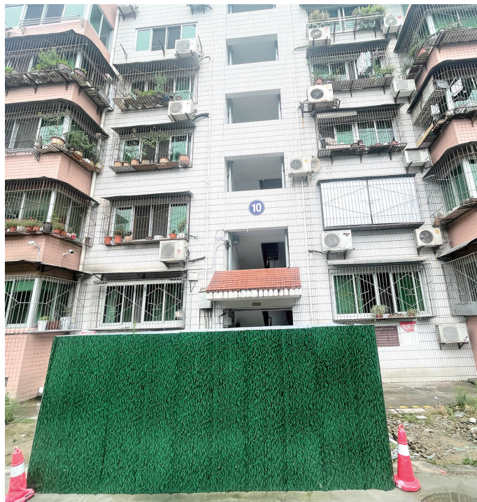
因一楼业主出面阻拦施工,现场只能被围挡封闭。
