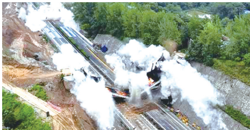
京港澳高速公路湖北北段一处天桥爆破现场。
