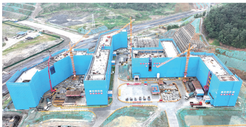
昨日,厦门路学校教学楼主体完工。
