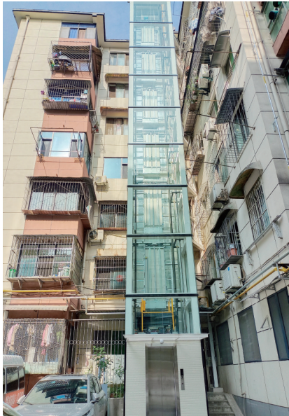
税务局小区2栋、3栋电梯加装完成。
