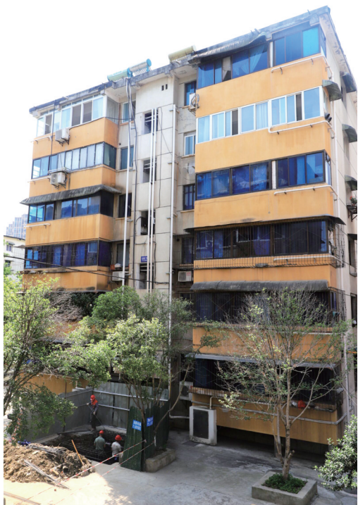
5月12日,15栋楼的电梯加装工作启动。
