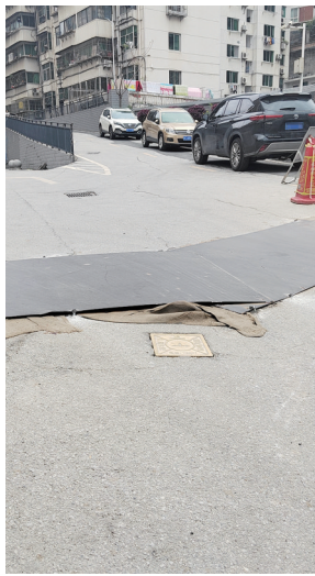
施工方重新焊接了钢板。
