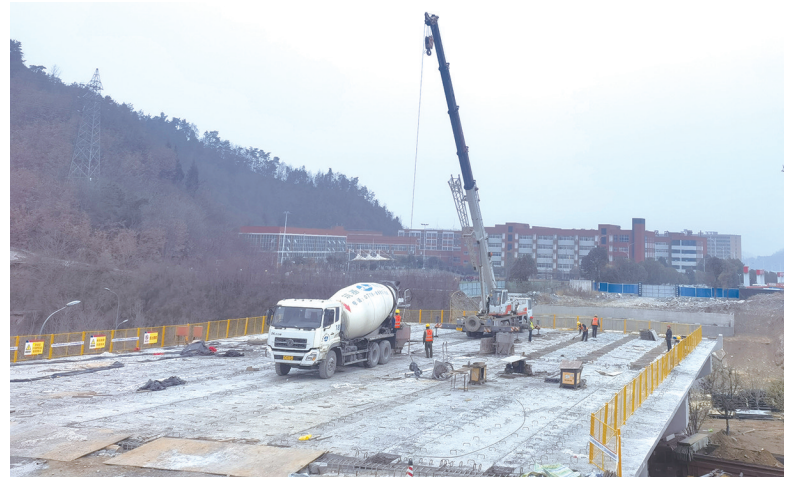
施工人员正加紧建设桥梁主体工程。
