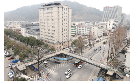
目前人行天桥主体已经完工。
