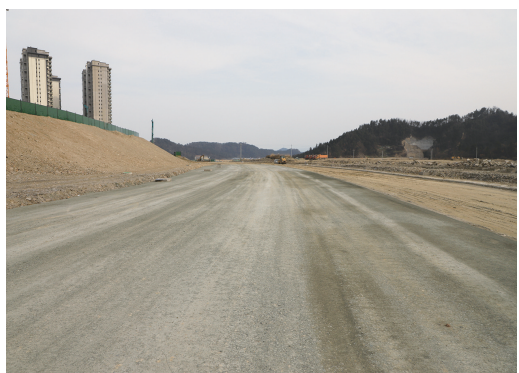
厦门路(一期)水稳层铺设进度过半。
