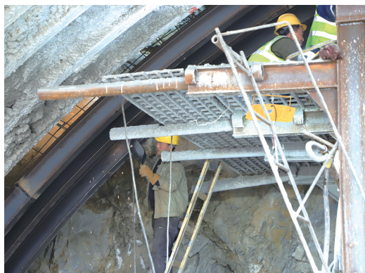
幸福路(二期)项目2号隧道,施工人员在安装焊接拱架。
