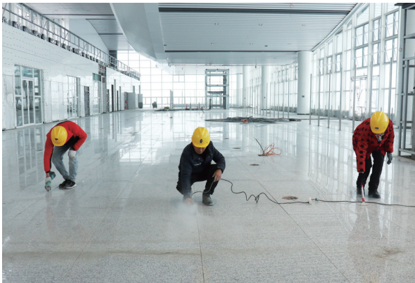
武当山机场国际航站楼项目建设现场，工人们忙着完成站内地砖铺设和扫尾工程。图/通讯员 徐世成
