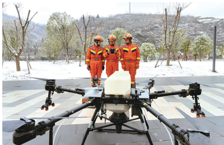
消防部门利用无人机撒盐对建筑顶棚进行融雪除冰作业。
