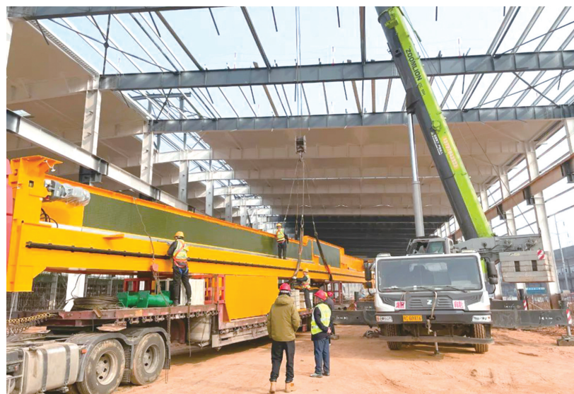
施工人员使用80吨的吊车吊装行车。
