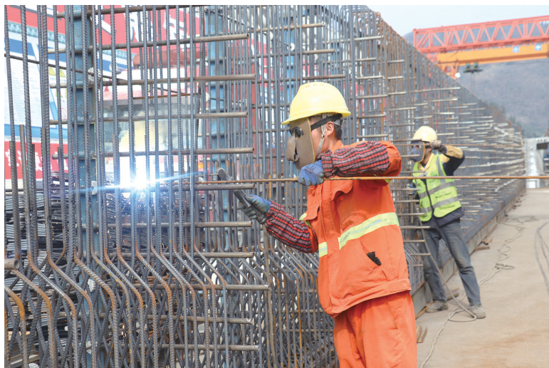
十巫北高速项目建设现场,工人对T梁进行钢筋绑扎。
