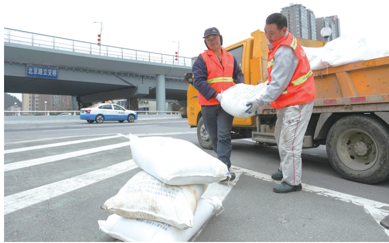
昨日,市政工程管理处工作人员在北京路立交桥摆放融雪剂。
