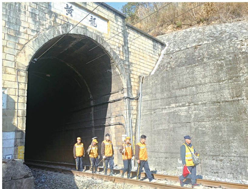
花果桥隧维修工区工作人员沿线巡视,确保列车畅通无阻。
