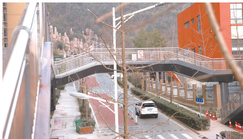
阳光小学人行天桥建成投用。(资料图片)
