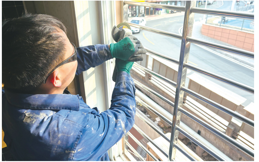
工作人员正在对一处违规外窗铁栅栏进行拆除。
