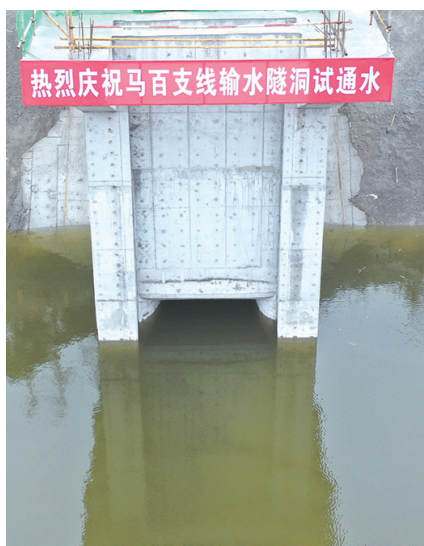
闸门升起,马家河水库的水流入隧洞。
