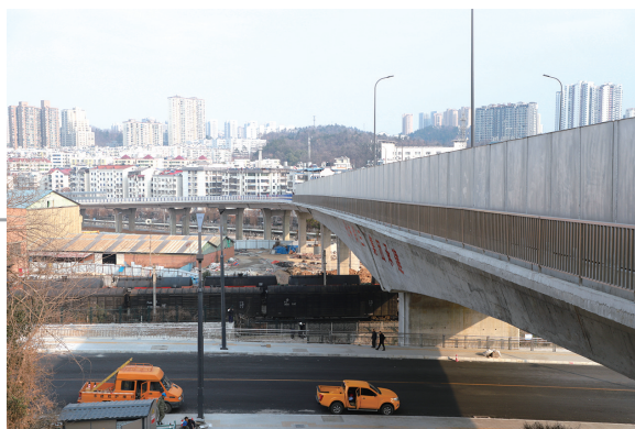
朝阳南路由下穿变为上跨铁路桥。
