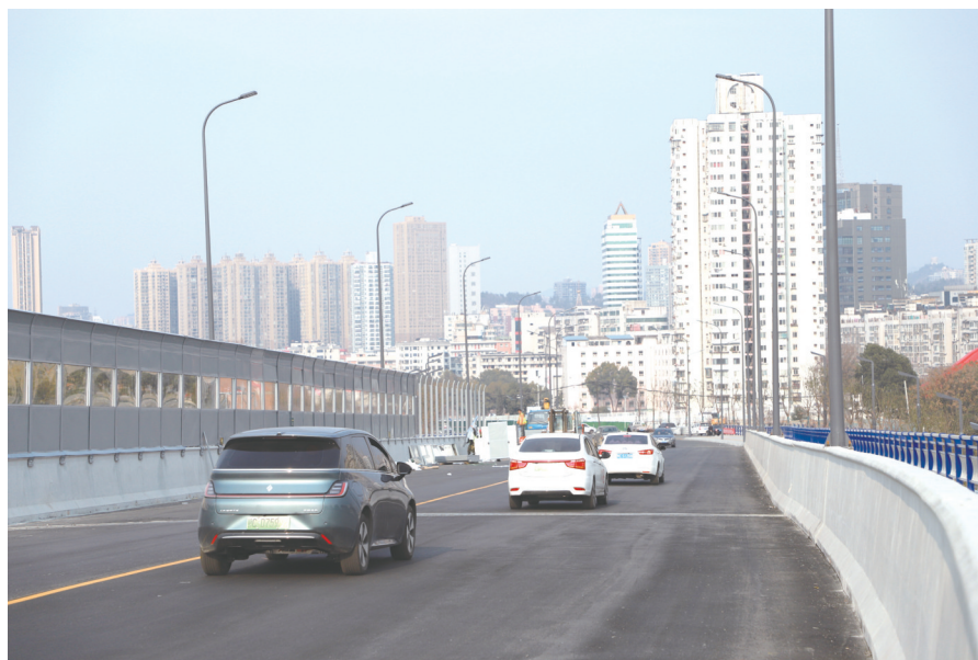
朝阳南路改线工程将极大方便沿线居民的日常交通出行。
