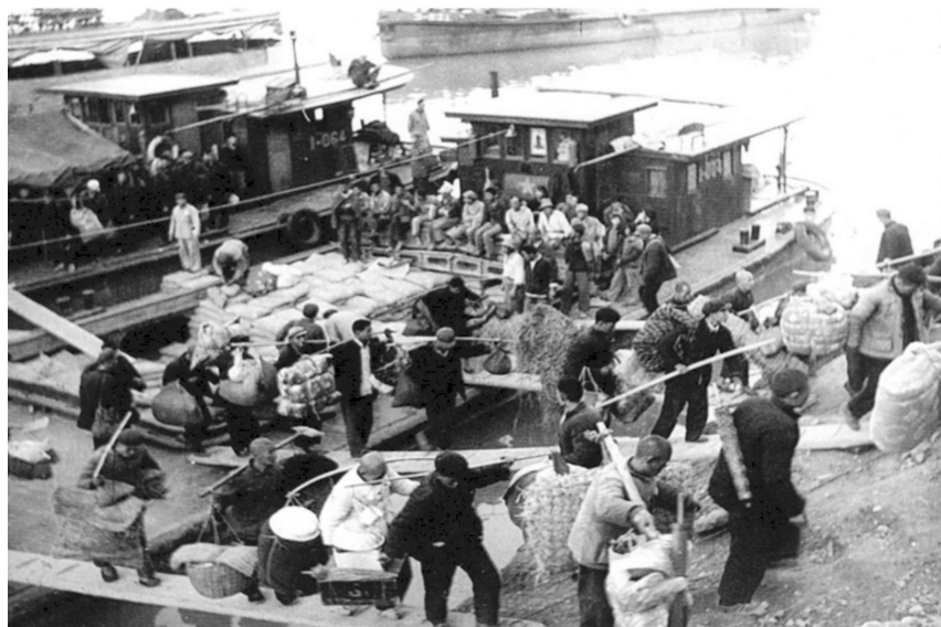
支援二汽的各地建设者从邓湾码头上岸,奔赴十堰施工现场。(资料图片)
