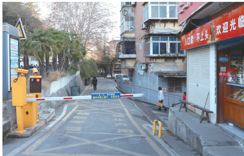
热心业主垫资安装道闸和摄像头。
