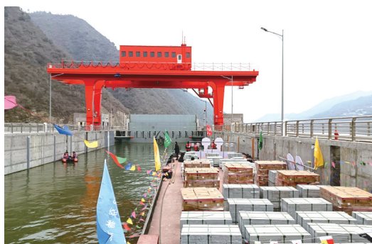
货船驶入孤山航电枢纽闸室,等待过闸入江。
