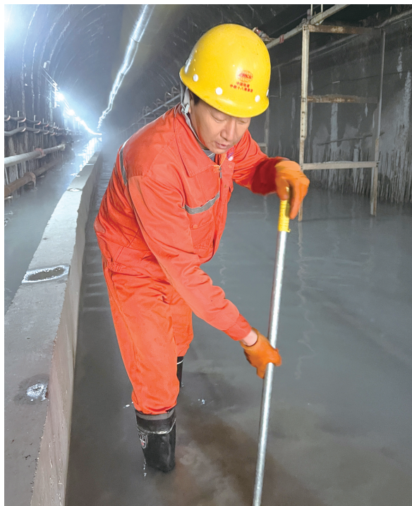
杨立新正在检修轨道。
