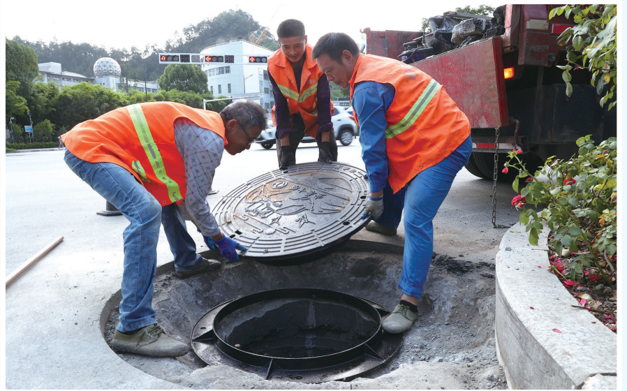
6月底开始,我市在城区80余条主次干道开展综合管沟防沉降井盖安装工作。(资料图片)
