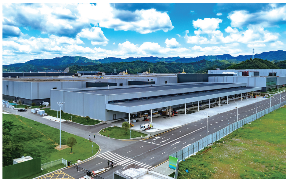
远景动力零碳智能电池产业园甫一落地便火力全开(资料图片)。
