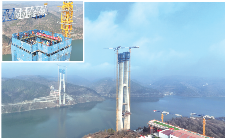
西十高铁汉江特大桥P4主塔顺利封顶。
