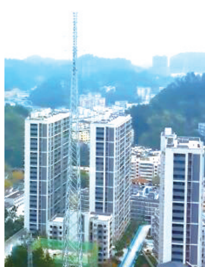
高高的电力铁塔矗立在山顶。
