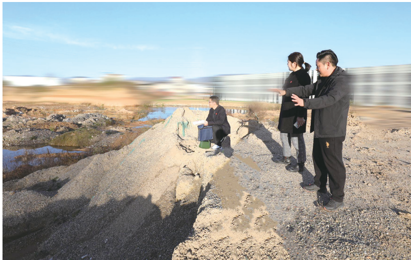
在工地古墓葬现场,法院工作人员核查案情。
