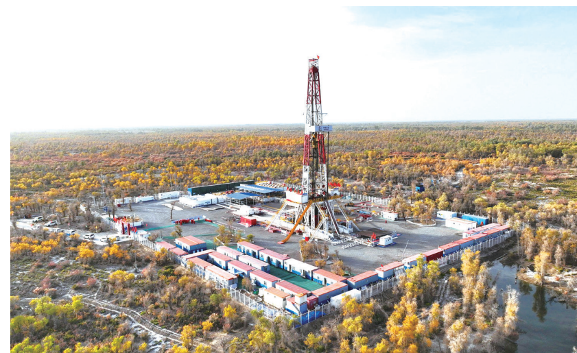
中国石化“深地一号”跃进3-3XC井。
