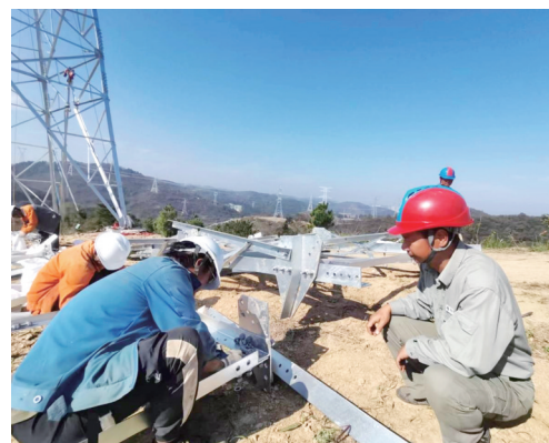
邹帮喜(右一)向施工人员交代作业任务、安全风险。
